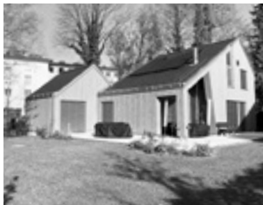
Foto: Zimmerei Holzbau Burgschwaiger
