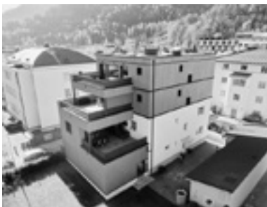
Foto: P. Lienbacher Holzbauwerk
