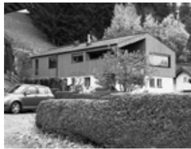
Foto: Zimmerei Holzbau Burgschwaiger
