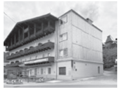
Foto: Zimmerei Holzbau Burgschwaiger
