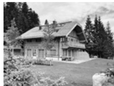
Foto: P. Lienbacher Holzbauwerk
